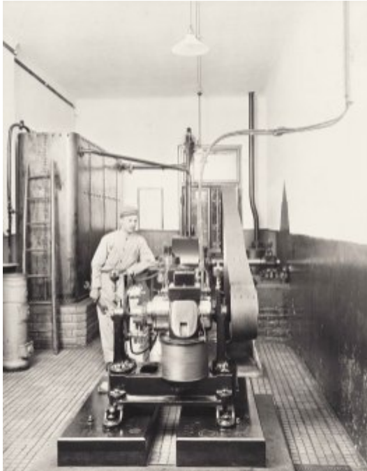
Generator im Maschinenraum. Aus: Unser Heim am Semmering © Gemeinde Semmering
