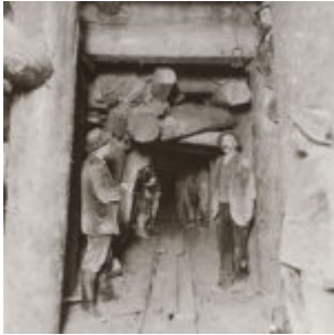
Arbeiter beim Tunnelbau, 1905 © Technisches Museum Wien, Eisenbahnarchiv
