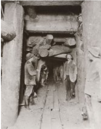
Arbeiter beim Tunnelbau, 1905 © Technisches Museum Wien, Eisenbahnarchiv
