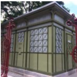
Denkmalgeschützte Toilettenanlage von Wilhelm Beetz im
